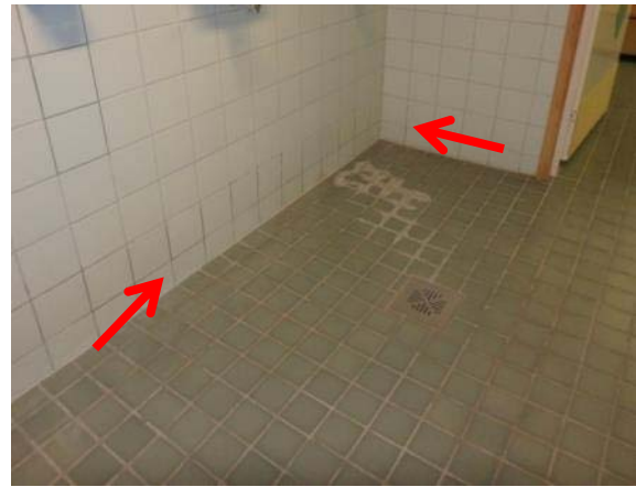
Kuva 30. Liikuntasalin pesutilan seinissä on kosteutta, mikä vähentää pesutilojen teknistä käyttöikä
