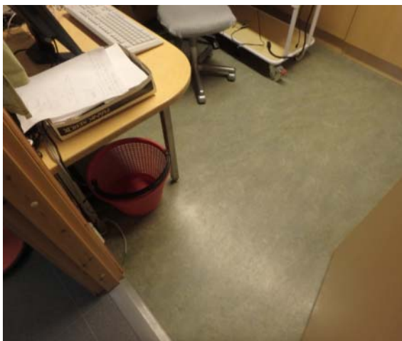
Kuva 15. Muutamassa tilassa on edelleen linoleumimattoja
