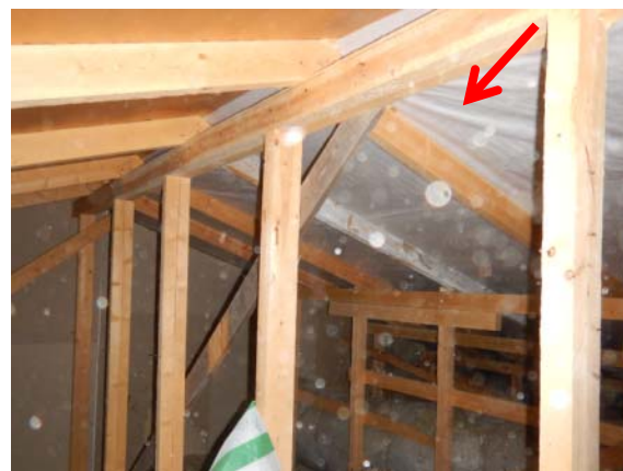
Kuva 80. Osa rakennuksen vesikatteista on uusittu.
