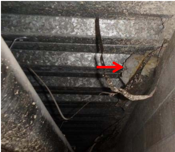
Kuva 27. Mahdollisesti valun aikaisia mineraalivillatilkkeitä.
