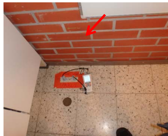
Kuva 20. Välipohjan rakenneavaus- ja kosteusmittauskohta.
