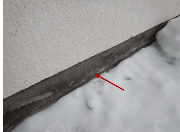
Kuva 4. Sokkeliin jäänyt surritappi.
