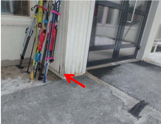
Kuva 41. Rakenneavaus tuulikaapin 119 ulkoseinärakenteen alaosaan.
