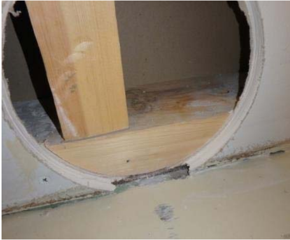
Kuva 67. Väliseinän rakenneavaus, teknisen työn luokka VS2.
