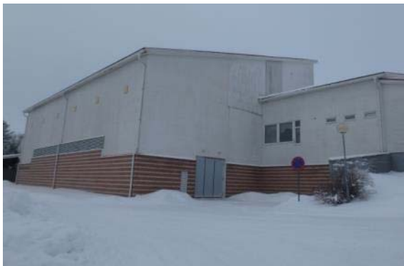
Kuva 51. Rakennuksen julkisivu liikuntasalin kohdalta.
