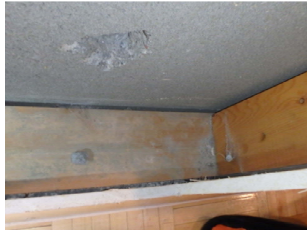
Kuva 70. Harkkorakenteisen väliseinän sisäpuolinen koolaus.
