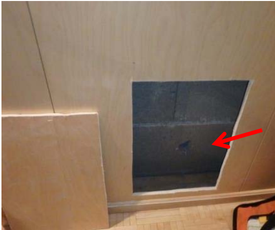
Kuva 69. Väliseinän rakenneavaus, auditorio.
