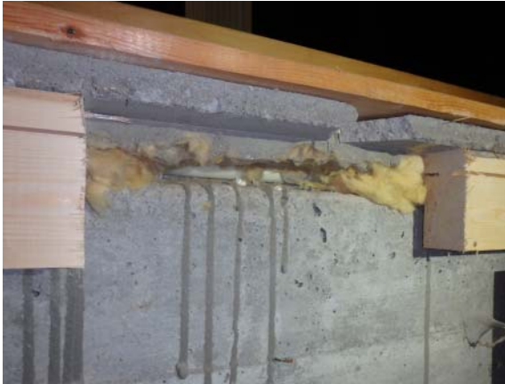
Kuva 35. Seinän rakenneavaus MV4. Seinän yläosassa on valun aikaisia laudoituksia ja mineraalivillaa.
