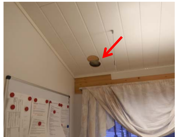
Kuva 74. Rehtorin huoneen sisäkaton rakenneavaus.
