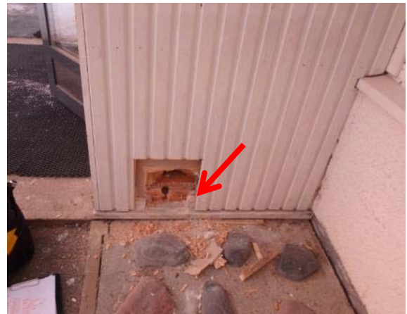
Kuva 44. Rakenneavaus tuulikaapin 101 ulkoseinän alaosaan.
